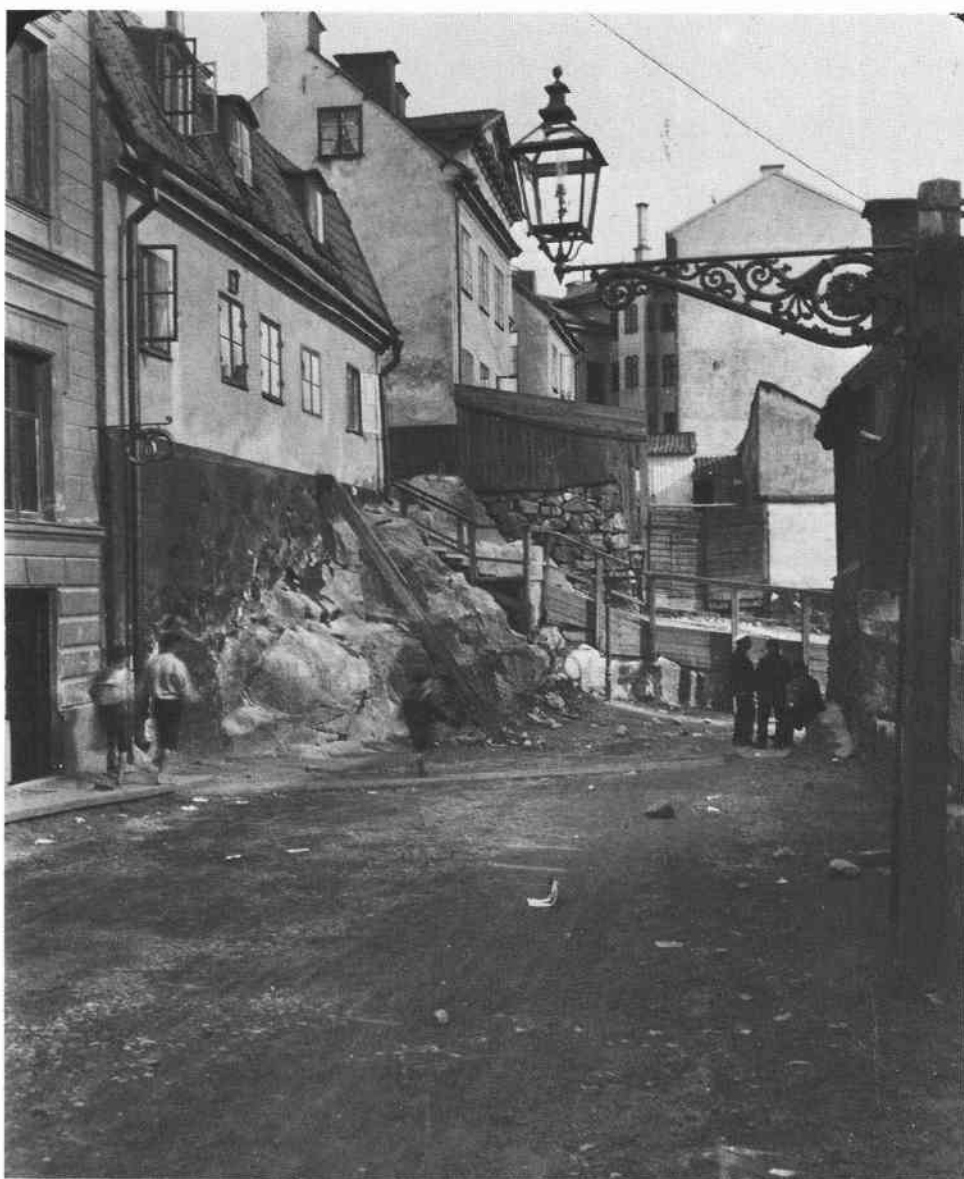
Norrteljegatan vid Iverssons Gränd omkring år 1900. Till vänster byggdes senare Whitlockska skolan. Intill gaslyktans kupa syns en gavel på den malmgård som Olle Engkvist och Cyrillus Johansson försökte rädda på 1920-talet. På platsen byggdes i stället hyreshuset Norrtälje 18, sedan en stor del av berget sprängts bort.
