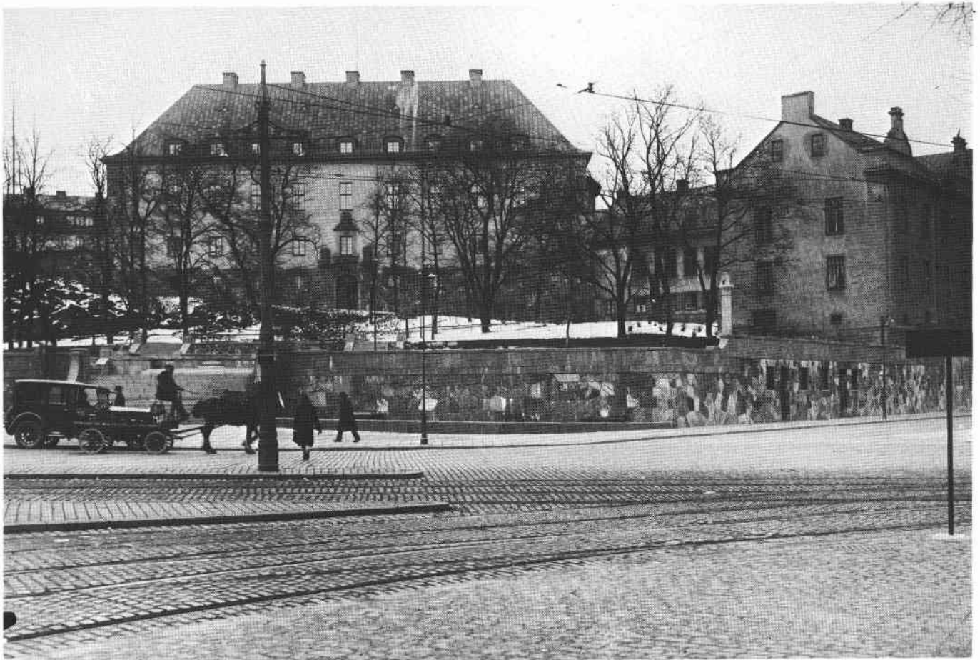
Timmermansordens byggnader i slutet av 1920-talet. Till höger en flygel på den äldre huvudbyggnaden. Sedan nybyggnaden färdigställdts inrymdes här under några år Anna-skolan, en privat flickskola som 1933 slogs samman med Detthovska skolan på Eriksbergsgatan. Samma år revs det gamla Eriksberg.
