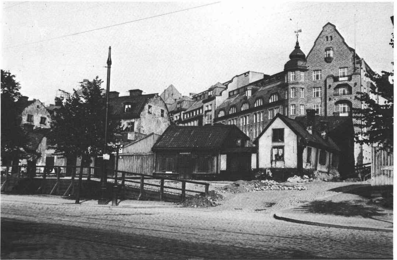
Södra delen av Roslagstorg år 1913. I kv. Trojenborg är de Whitlockska och Detthovska skolorna just färdigställda vid Eriksbergsgatan. De gamla husen i kv. Lerlafven är delvis utrymda inför rivning, några år senare hade även torget försvunnit och uppgått i kv. Asken.
