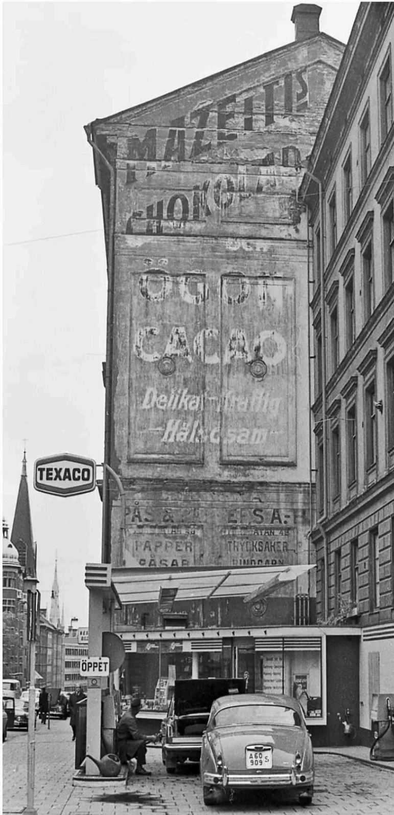
Fasaden på Upplandsgatan 19 B då det fanns en bensinmack där.
