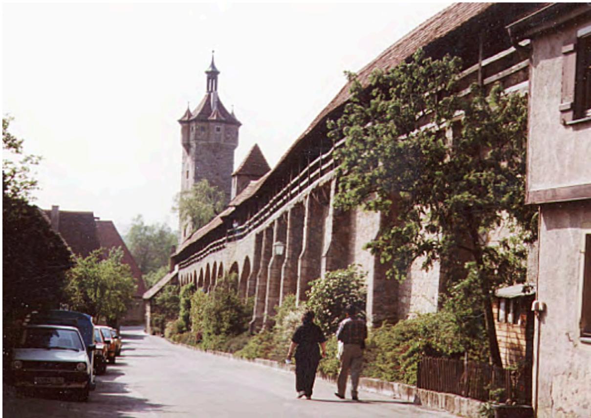
Elastiskt murverk som skyddas under fredstak.
