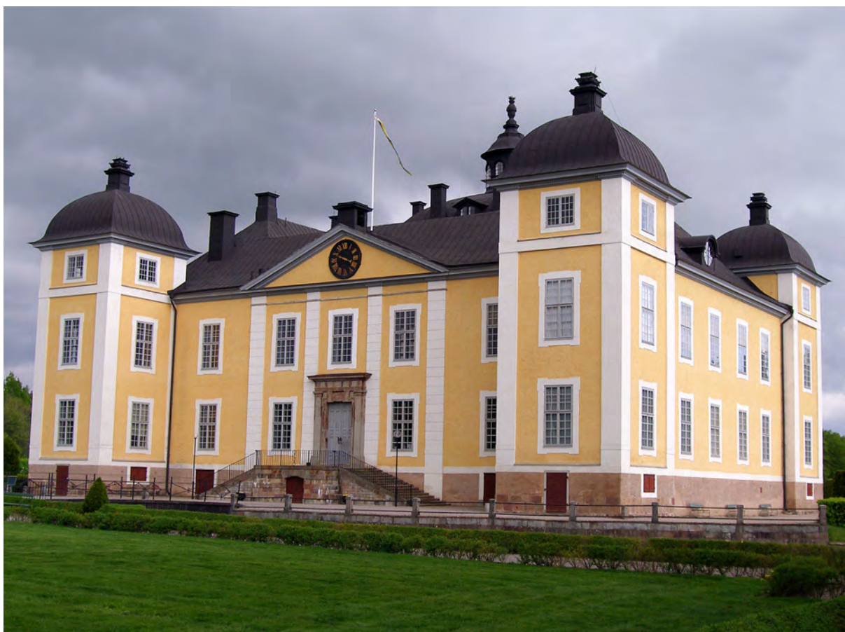
Strömsholms slott efter Härlemans ombyggnad i mitten av 1700-talet. Senast fasadrenoverat 1985-1987 med smärre putsläggning och omkalkning.
