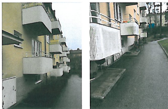
Balkonger med plåtskärm
