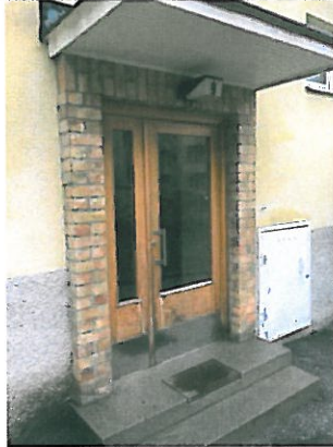
Entréparti med sparkplåt
