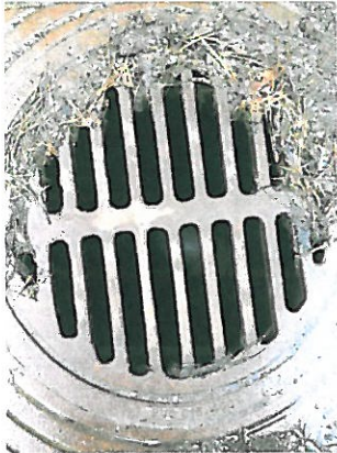
Dagvattenbrunnar saknar helt fallskydd Montering av fallskydd
