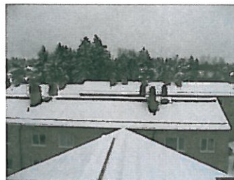
Nockbrygga/stegar för ventilationshuvar.
