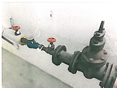
Vattenmätare enkonsol med digitalmätare Radiatorventil/känselfkropp Rörledning i källartak
