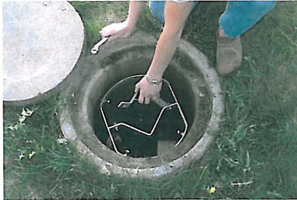
Dagvattenbrunnar saknar helt fallskydd Montering av fallskydd
