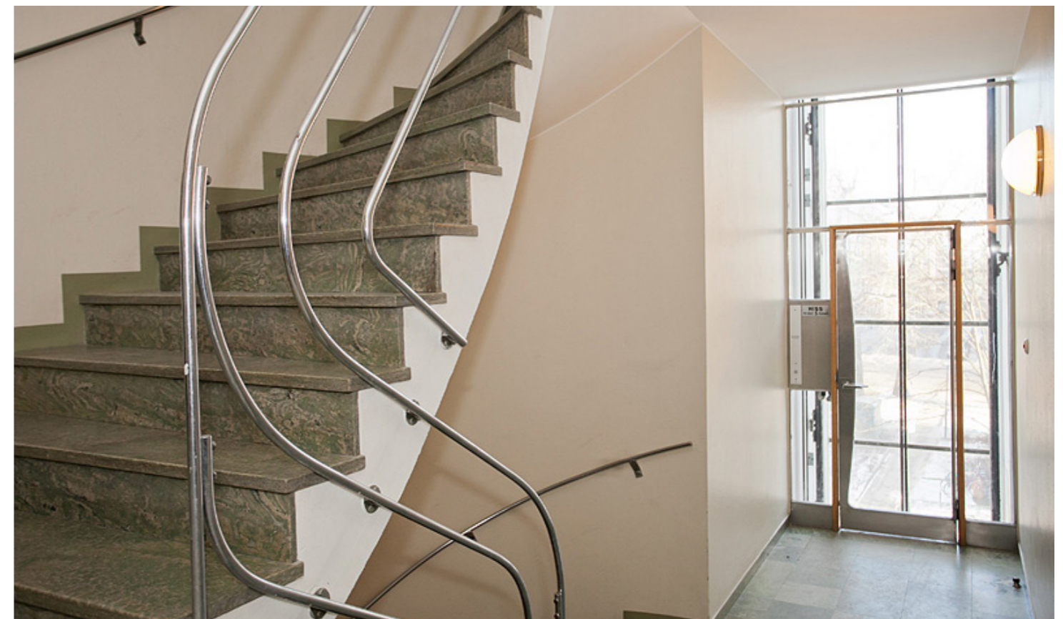
Ledstång av böjda stålrör, en teknik som slog igenom under funktinalismen.
